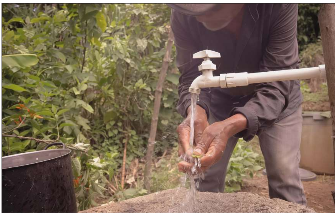
La cobertura en comunidades con 80 o 90 por ciento de tomas instaladas reciben agua apenas cada 40 o 45 días. Cántaro Azul
