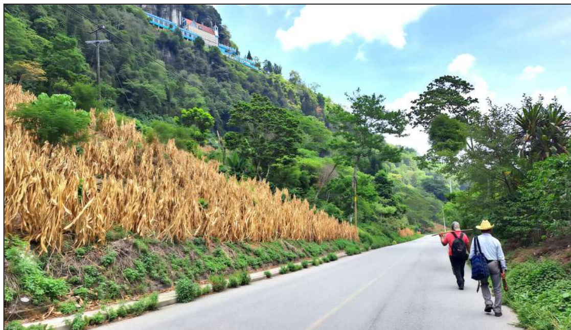
Reparación de fuga en las tuberías rumbo a Santiago Ecatlán. Tania Escobar Fuentes
